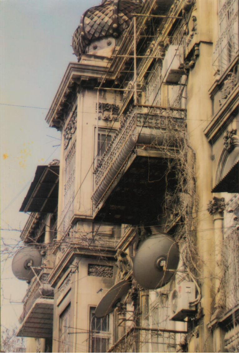
Şəmsi Bədəlbəyli 24 – sökülmüş binası
